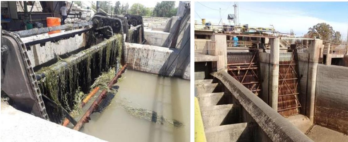
Figura 26. Sistema de extracción mecánica en la Central Hidroeléctrica Ing. Cesar Cipolletti. Izquierda: acumulación de material vegetal en el sistema limpia rejas. Derecha: Sistema de extracción mecánica limpio.
