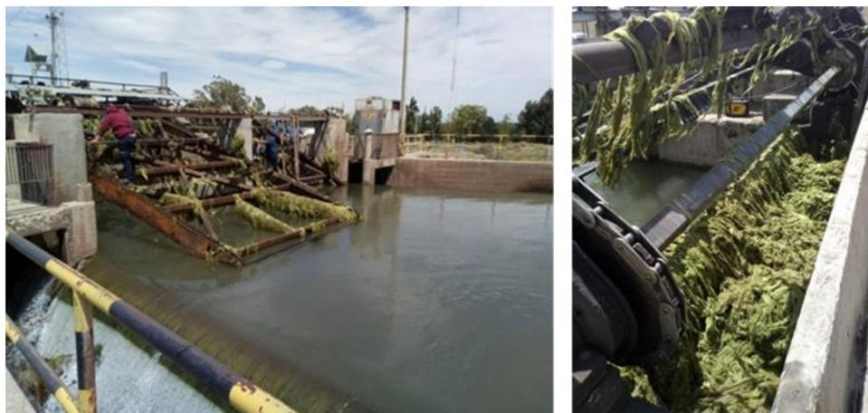
*Figura 27. Acumulación de vegetación acuática en el sistema de limpia rejas de la Central Hidroeléctrica Ing. Cesar Cipolletti.*
