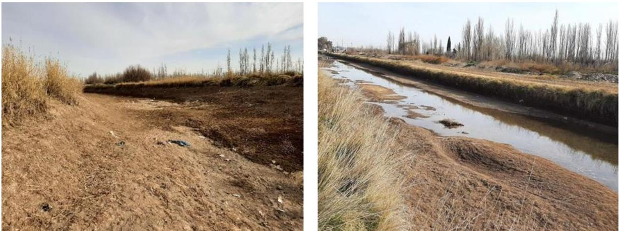
*Figura 21.* Bancos de sedimentos en el Canal Principal en época de no riego (sin agua).
